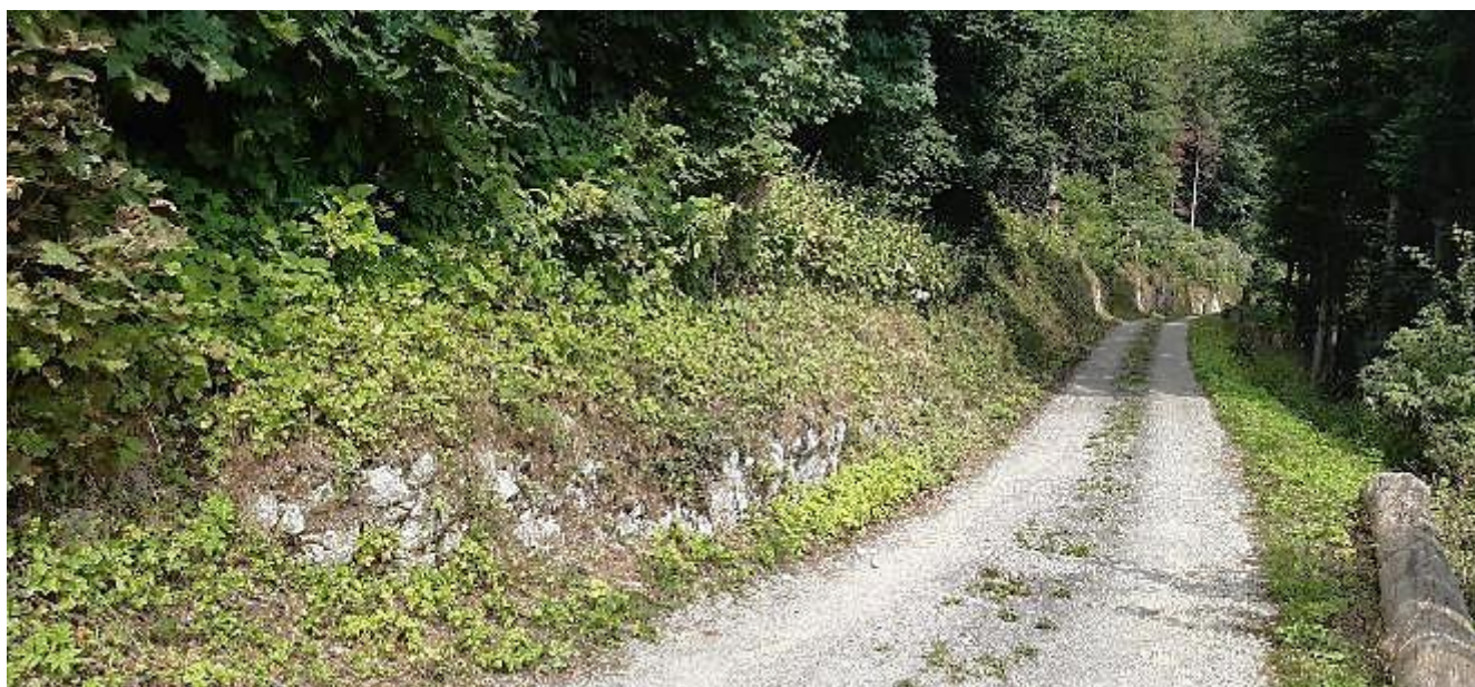
Vue sur la partie en forte pente de la desserte ; ILEX août 2021
